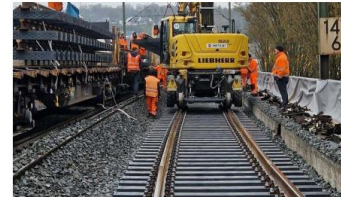
Bahnschwellen aus recycelten Kunststoffabfällen; Quelle: Sicut
