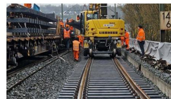
Bahnschwellen aus recycelten Kunststoffabfällen; Quelle: Sicut
