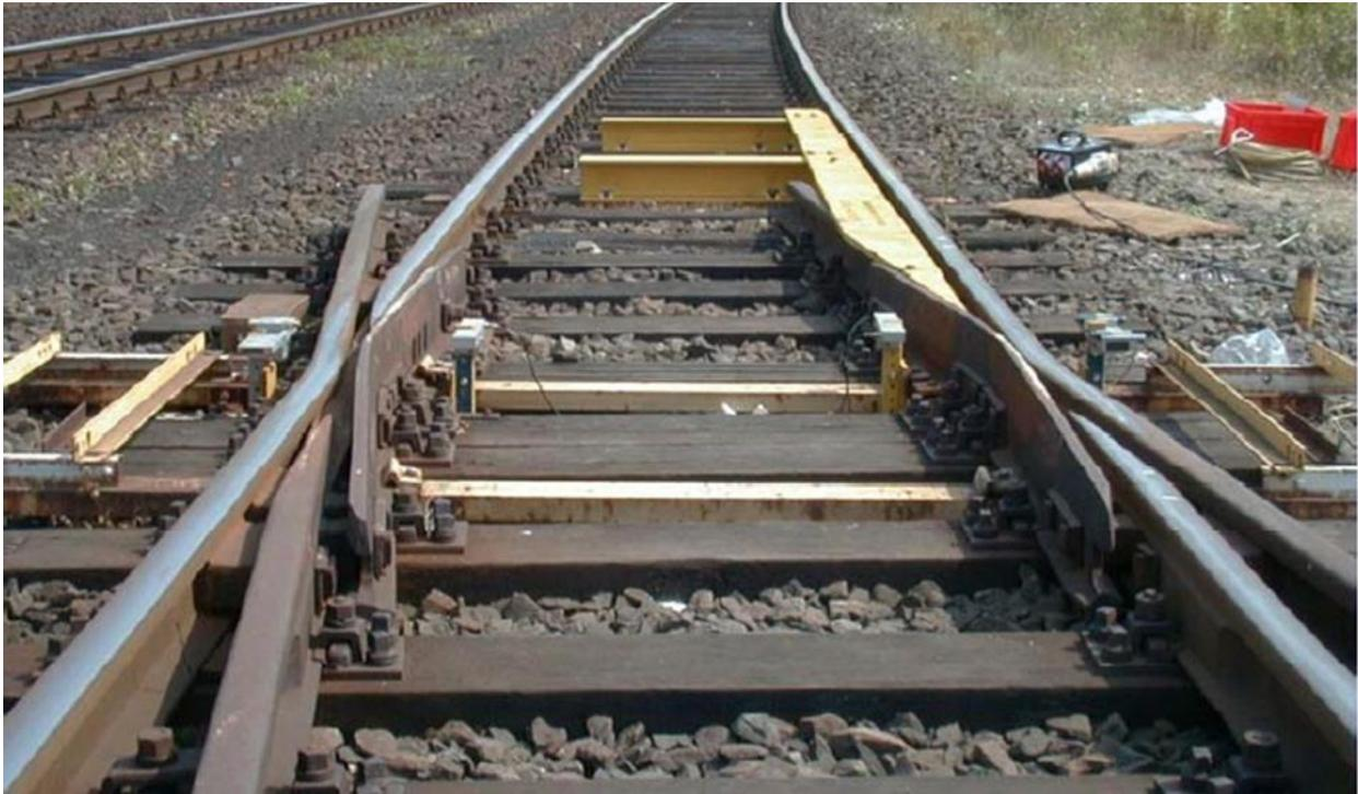
Abbildung 6 Beispiel einer Bogenkreuzung im Prüfgleis bei der DB Systemtechnik, Minden
