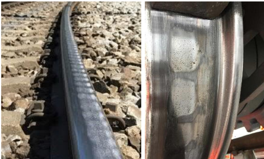
Figure 10 : Taches brillantes sur le rail et taches sur la roue représentant les zones de glissement Stick-Slip (source : zb Zentralbahn AG)
